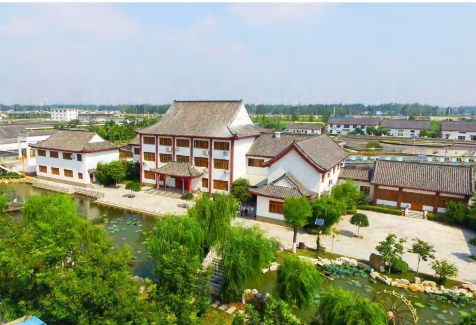
聊城市环能净水有限公司第二污水处理厂
