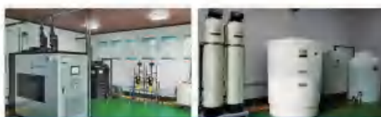
济宁新城自来水公司1万吨/天 (次氯酸钠发生器:1kg/h×1)
