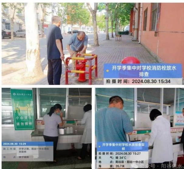
卫生间、消火栓等关键部位正常使用情况进行现场排查，对校内供水管网进行全面冲洗，排出长时间留置在管网的“死水”，通过对出水水样浑浊度、余氯等主要指标现场检测，细致研判水质情况，
